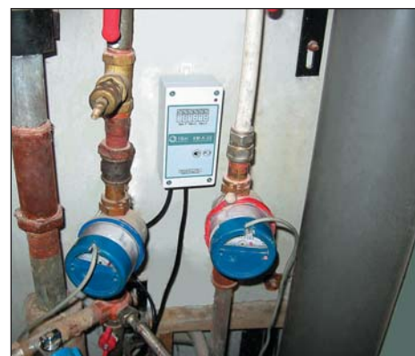
Рис. 7. Установка квартирного контроллера КМ-К-3Z
