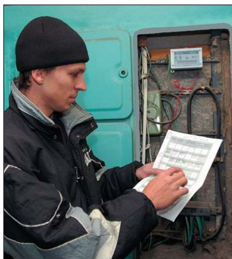
Рис. 8. Установка этажного контроллера КМ-К-8Z
